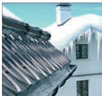
Tetti e grondaie
